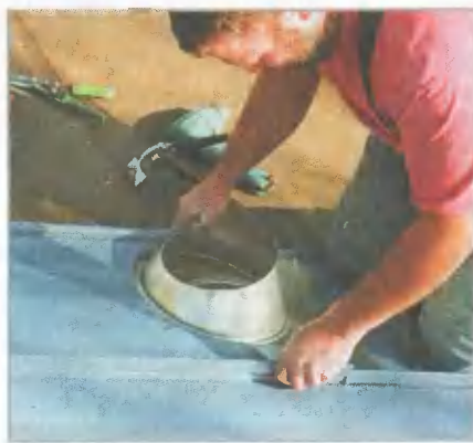
Между гребнями. Если проходное отверстие под дымоход приходится на участок между фальцами, края кожуха фальцуют и сажают поверх нижней части кровельной панели (фото слева). Верхнюю часть панели укладывают поверх фланца кожуха и приворачивают (фото справа)
