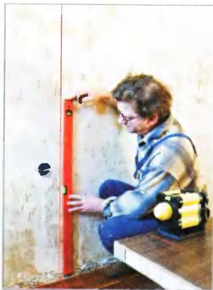
Вертикальную линию для наклейки обоев на стене разметил с помощью лазерного уровня
