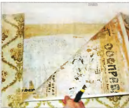
Хорошо смоченные водой обои отставали от стен без особого труда
