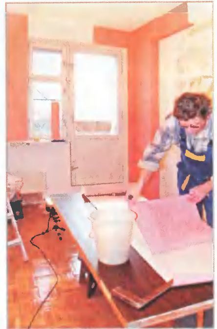
Смазанный клеем кусок обоев надо сложить влажной поверхностью внутрь, загибая его от краёв к центру
