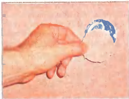
Острым ножом в обоях, закрывающих пластиковые коробки для установки электрических розеток, я вырезал отверстия
