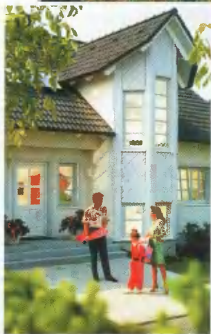
Окна эркера имеют различную высоту. Они привлекают внимание и одновременно обеспечивают хорошую освещённость внутренней лестницы
