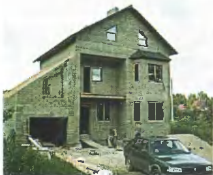
Устройство зркера в трёхслойной стене. (Дом в г. Балашиха Московской области)
