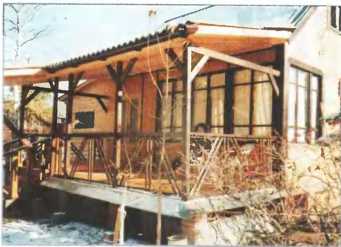
Новая открытая терраса представляет собой каркасную конструкцию с основанием из бруса, опирающуюся на столбчатый фундамент
