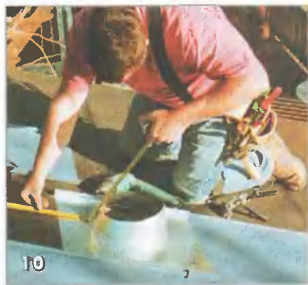
Между гребнями. Если проходное отверстие под дымоход приходится на участок между фальцами, края кожуха фальцуют и сажают поверх нижней части кровельной панели (фото слева). Верхнюю часть панели укладывают поверх фланца кожуха и приворачивают (фото справа)
