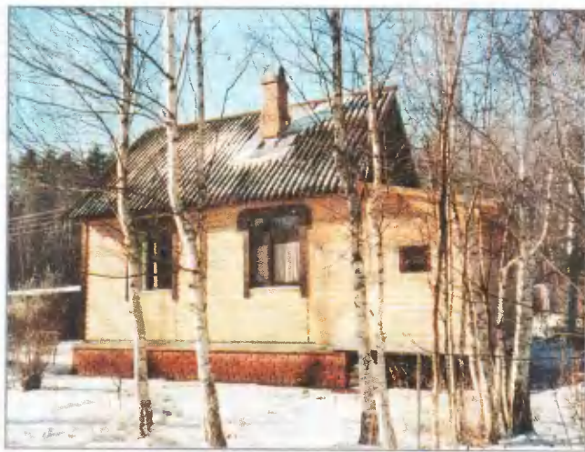
В северной пристройке размещены кухня и туалет с душевой кабиной
