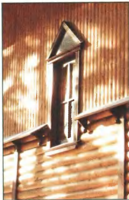
Даже простое изменение направления прибиваемого блокхауса и небольшие карнизы заметно украшают отделку
