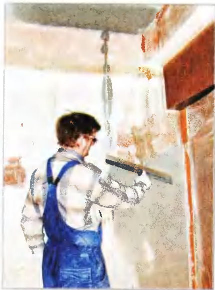
Для выравнивания одной из гипсовых перегородок пришлось нанести слой «Ротбанд» толщиной до 4 см. Металлические маяки, установленные на стене, упростили выравнивание поверхности
