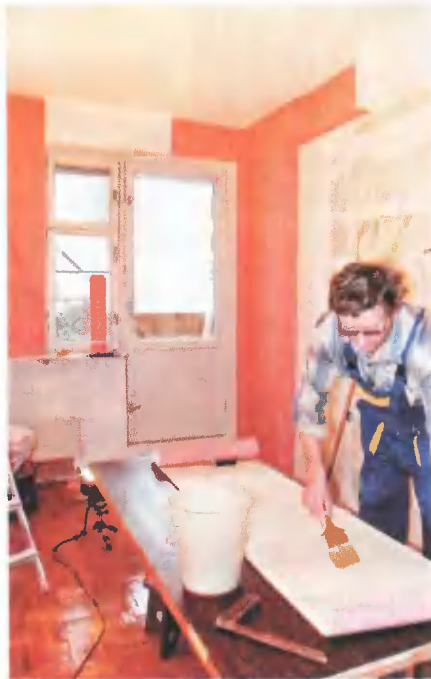
Равномерно распределять клей на обоях удобно малярным валиком на длинной ручке или широкой кистью
