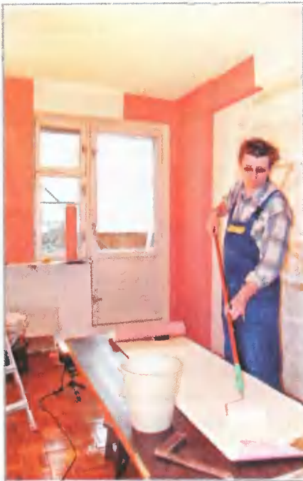
Равномерно распределять клей на обоях удобно малярным валиком на длинной ручке или широкой кистью
