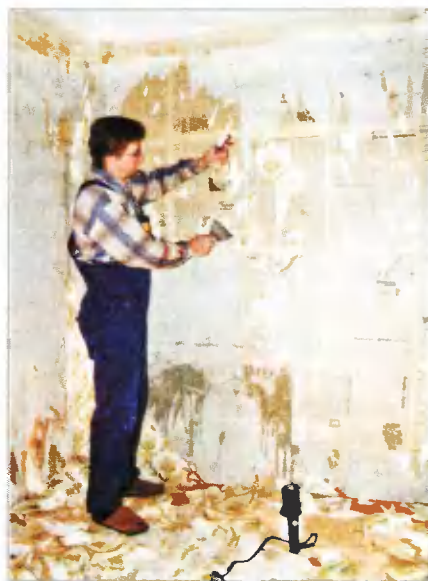
Для снятия небольших фрагментов бумаги со стен удобно использовать ручной распылитель воды и шпатель
