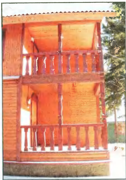
Ограждение балкона и крыльца получилось красивым и надежным
