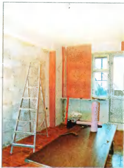
Для нарезки и нанесения клея на обои я использовал полотно старой даери, уложенное на табуретки. Несколько нарезанных кусков обоев разместил на его поверхности стопкой
