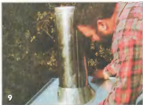
Если проём совпал с фальцем. В этом случае в нижней части фартука проходного элемента формируют специальный гребень (фото слева). Кровельные листы тщательно подгоняют к трубе и приворачивают поверх верхней части кожуха (фото справа)
